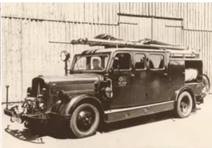
Von den heutigen Möglichkeiten zur Lösung der vielfältigen Aufgaben war die Werkfeuerwehr in Unterlüß noch weit entfernt, als sie 1912 lediglich ein Pferdegewiss und eine Handdruckspritze (Bild Mitte) besaß. Seit den dreißiger Jahren hatte sich die Ausstattung deutlich verbessert: Motorfahrzeuge mit ausfahrbaren Leitern und Schläuchen (Bild rechts) und Anhänger mit Sondergerät (Bild links) gehörten zur Standardausstattung der Feuerwehr.
